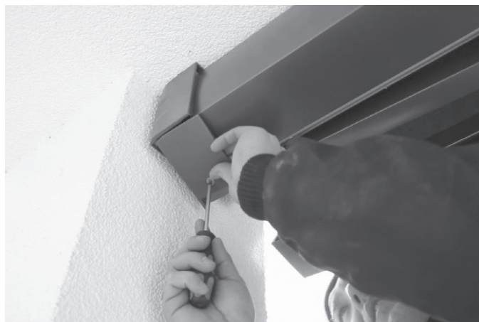
Fig. 16: Rimuovere le coperture delle mensole
