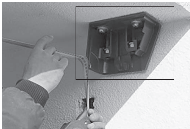
Abb. 07: Konsolen ausrichten (hier Bsp. Deckenmontage)
