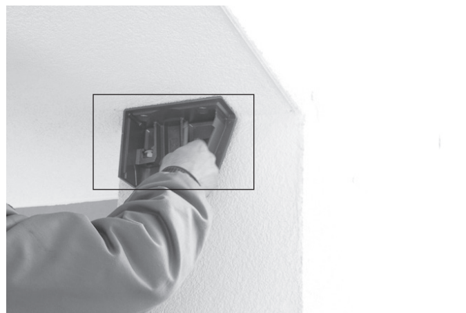
Figura 05: Transferir la plantilla de perforación (en este caso, para montaje en techo)
