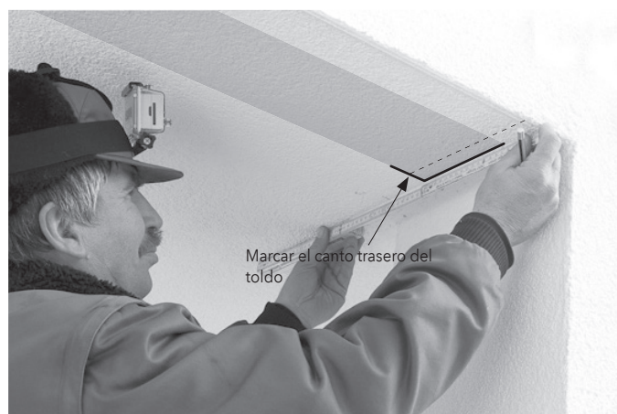
Figura 04: Marcar el borde trasero del toldo (en este caso, para montaje en techo)
