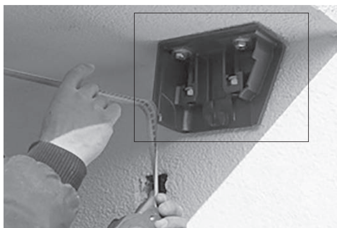
Figura 07: Alinear los soportes (en este caso, para montaje en techo)
