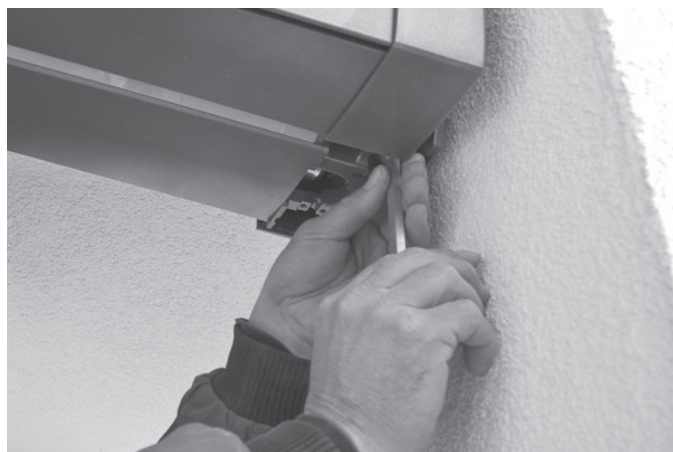
Fig. 11: pose des vis de blocage
