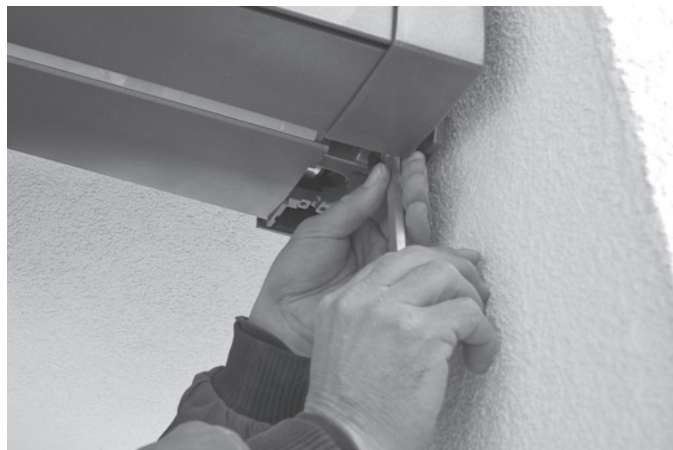
Abb. 11: Sicherungsschrauben setzen
