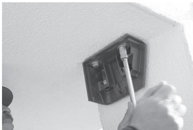
Fig. 08: Stringere le viti di fissaggio (qui nell'esempio il montaggio a soffitto)
