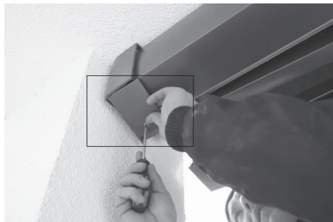
Fig. 12: Montare le coperture con la tenda da sole leggermente aperta
