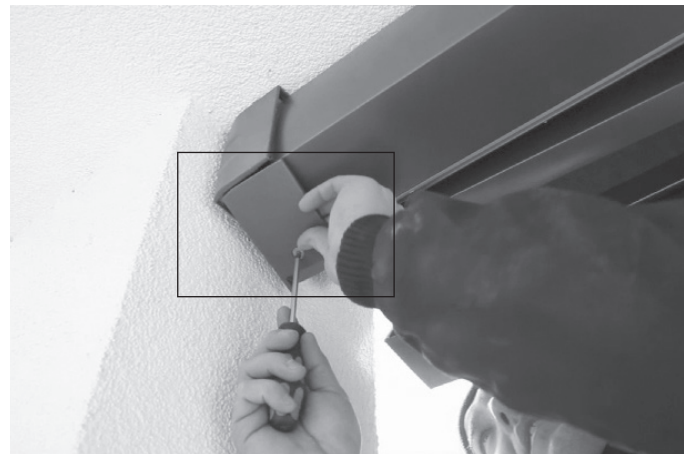
Abb. 12: Abdeckungen bei leicht geöffneter Markise anbringen
