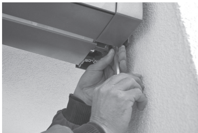
Figura 11: Instalar los tornillos de seguridad
