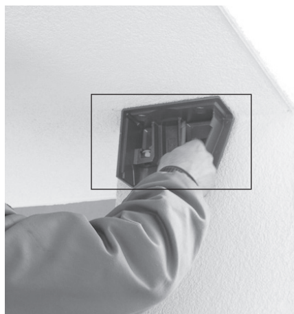
Abb. 05: Bohrbild übertragen (hier Bsp. Deckenmontage)
