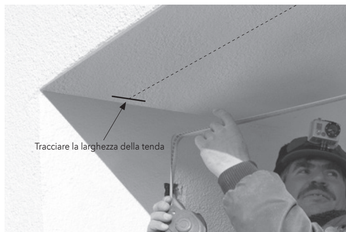
Fig. 03: Tracciare la larghezza della tenda (qui nell'esempio il montaggio a soffitto).
