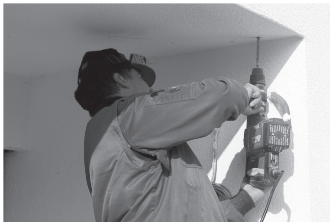
Fig. 06: perçages (exemple de fixation plafond)
