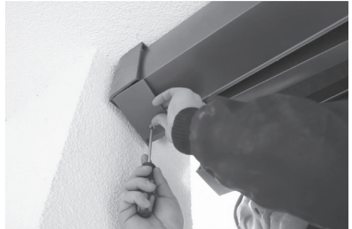
Abb. 16: Konsolen-Abdeckungen entfernen
